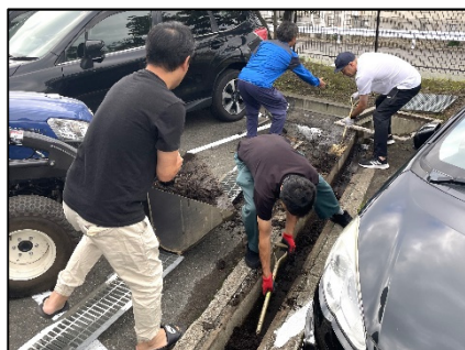
【駐車場の泥上げ作業】
